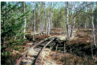
Stillgelegte Feldbahnstrecke (Spur 600)
