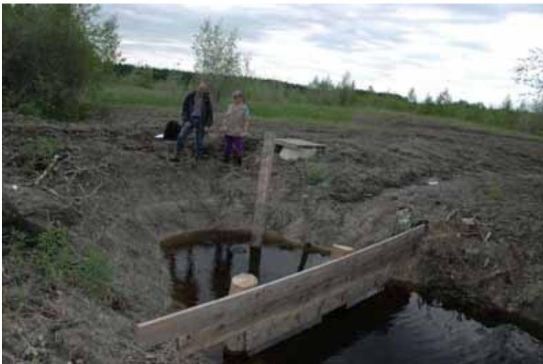
Um die Haltbarkeit der Überlaufbauwerke zu verlängern wurden stellenweise anstatt eines offenen Überlaufs Rohre eingebaut. Die Regelung der Stauhöhe erfolgt entweder direkt am Rohreinlass oder in einem zusätzlich errichteten Schacht.
