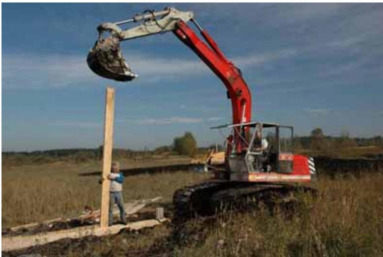
Nur an wenigen Stellen mussten zusätzlich Holzspundwände eingeschlagen werden um ein unerwünschtes Durchsickern des Wassers zu verhindern;
